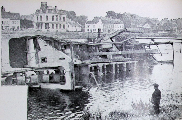
BAGGERMOLENMISERE OP DE MAAS. — De Maas schijnt niet de meest geschikte plaats voor baggermolens te zijn om er hun wroetend bestaan te leven. Binnen den tijd van twee maanden is dit nu al de tweede baggermolen, die daar al baggerend het loodje heeft gelegd. Het gevaarte in zijn ongewone houding.
